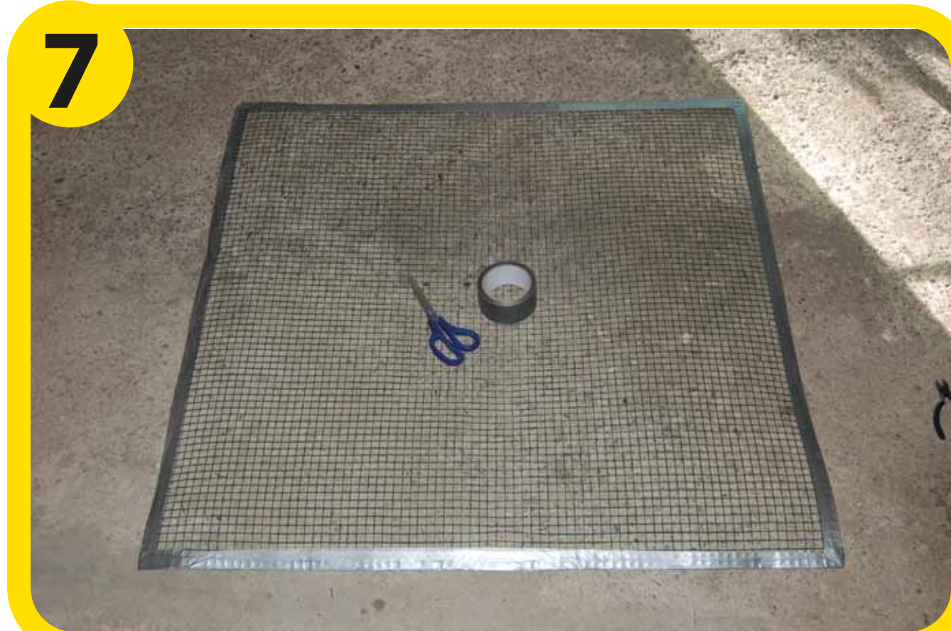
alla rete appena tagliata, applicare esternamente del nastro telato per evitare di farsi male quando si maneggerà il coperchio (le reti metalliche tagliate hanno delle punte)
