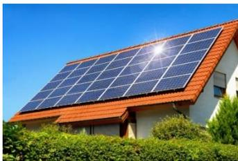
Il funzionamento dei dispositivi fotovoltaici si basa sulla capacità di alcuni materiali, opportunamente trattati, di convertire l'energia della radiazione solare in energia elettrica in corrente continua, senza bisogno di parti meccaniche in movimento.
