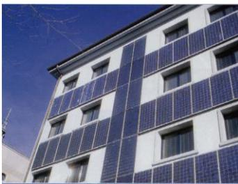
**Sistemi di facciata.** Le facciate di un edificio possono fornire grandi superfici e la possibilità di realizzare impianti di elevata valenza estetica. I sistemi FV possono essere usati come elementi protettivi di rivestimento e finitura delle pareti esterne o utilizzati come schermi solari per l'ombreggiamento delle finestre, contribuendo quindi al miglioramento delle prestazioni termofisiche dell'edificio.
